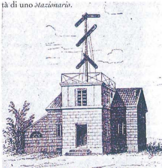
Una stazione telegrafica esistente a Blankenese, nei pressi di Altona, in Prussia. Il sistema utilizzato, come si rileva dalle braccia, non è però quello di Chappe
